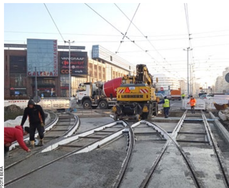
Łączny koszt prac przy pl. Dominikańskim wyniósł 3,6 mln zł
